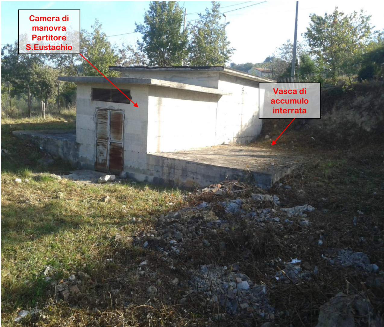
Foto n°3: Evidenzia l'area d'intervento con l'ubicazione del partitore S.Eustachio.
