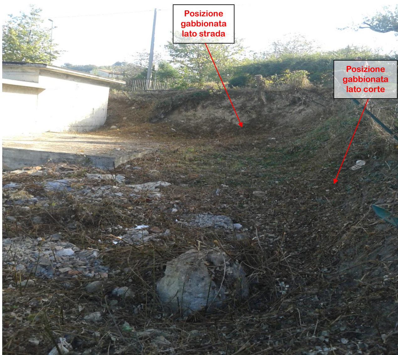
Foto n°1: Evidenzia l'area d'intervento con le due scarpate oggetto di sistemazione con gabbionate e la recinzione esistente divelta in più punti.
