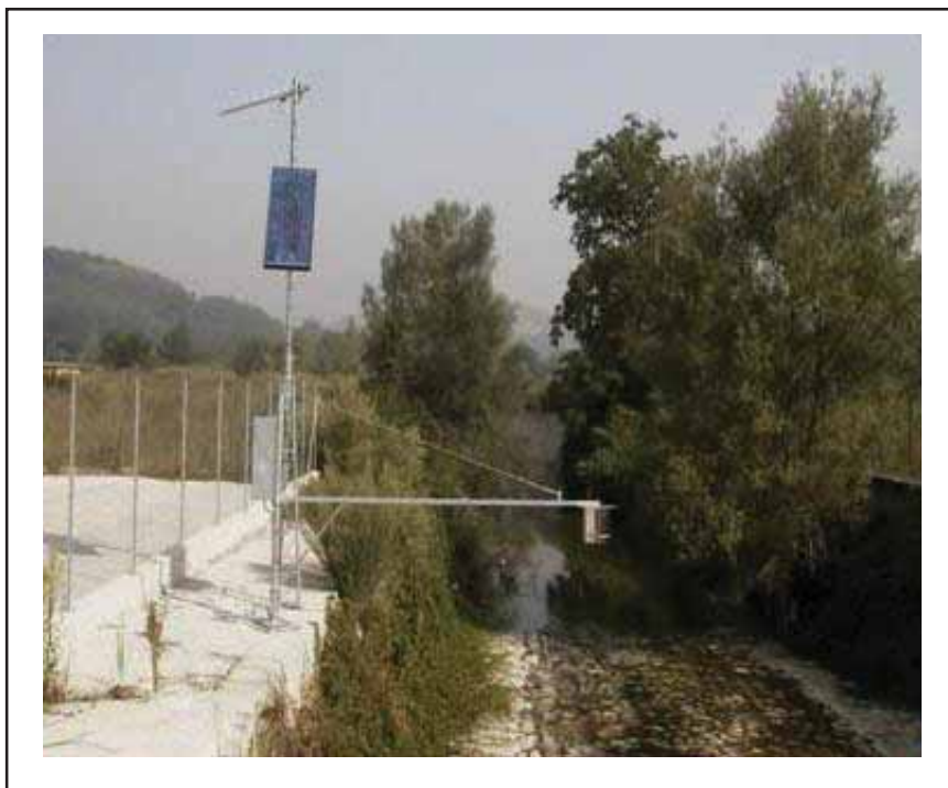
52 - Fiume Sabato in prossimità delle sorgenti Urciuoli - S. Stefano del Sole
