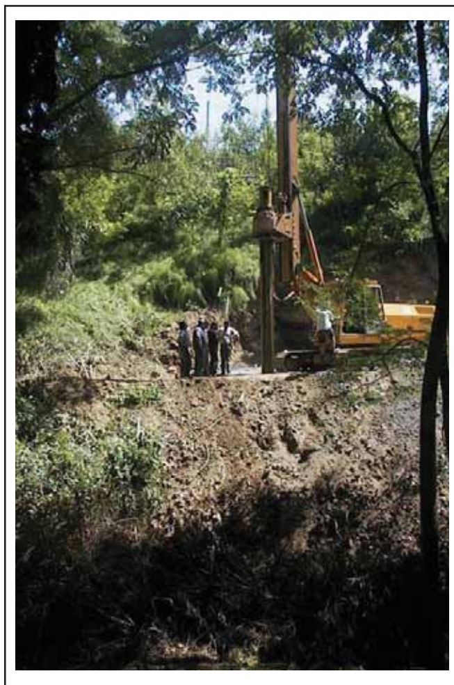
58 - Perforazione a monte della sorgente Pozzo del Sale - Grottolella
