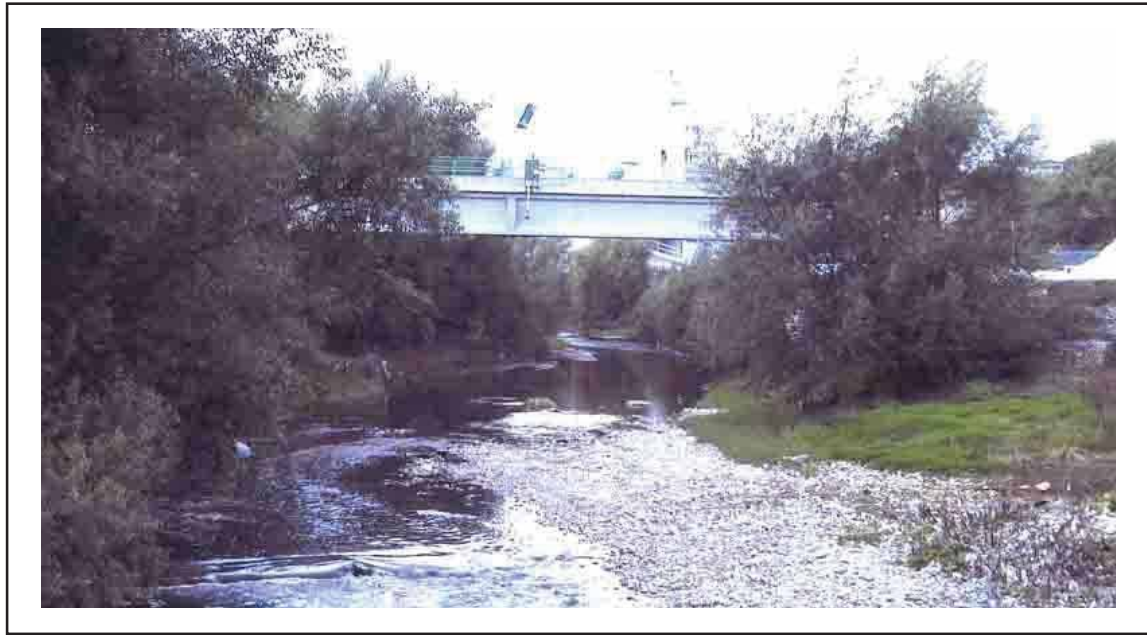
60 - Stazione idrometrica fiume Sabato - Manocalzati
