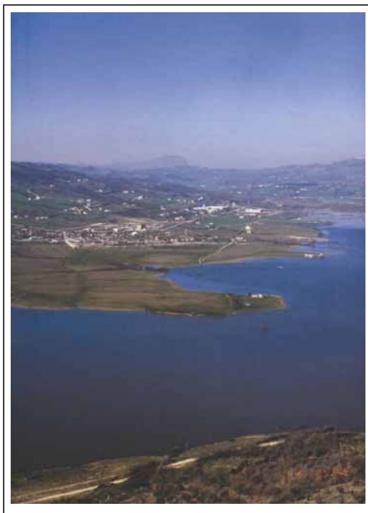
66 - Diga di Conza della Campania
